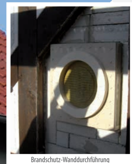
Leichtbauschornstein Bild 3
